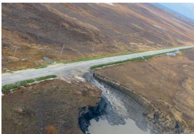
Рис. 1. Термоэрозия грунтов и образование оползней - сплывов из-за вытаивания пластового льда вблизи подъездной автодороги (аэрофотоснимок)
